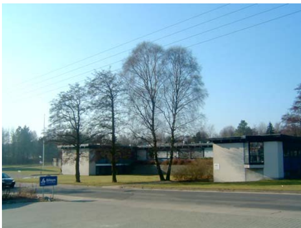
Eksisterende erhvervsbebyggelse set fra Ballevej
